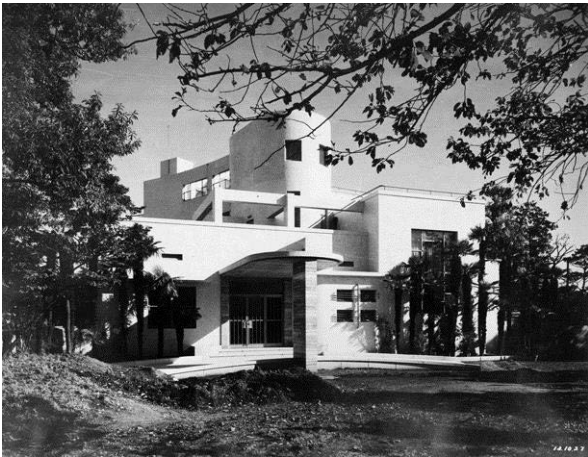
西側＝正面玄関外観
