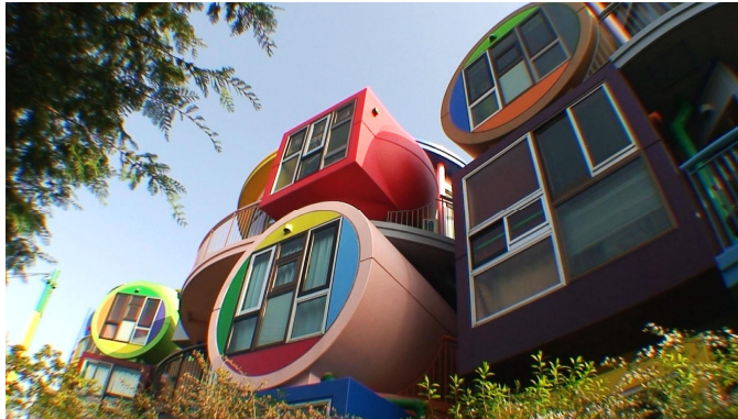
三鷹天命反転住宅 写真提供:株式会社 ABRF
